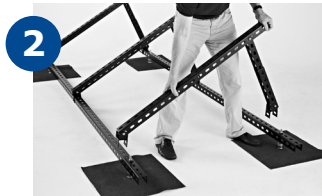
2 Afstand mellem u-skinner: 100 cm. Knægte monteres på u-skinner. Max. længde mellem knægte: 200 cm.
