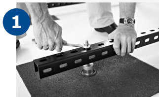
1 U-skinne monteres på fødder. Max. 270 cm mellem ankerpunkter. Er tallet mindre skal det være deleligt med 6 cm.
