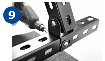
9 Fastspænding ved u-skinne af samtlige drop-in bolte. Når alle strenge er spændt opnåes stivheden.
