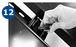
12 Efterspænding af solpaneler.
