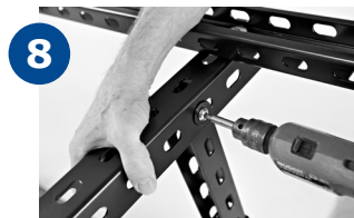
8 Fastspænding af skinner og knægte.
