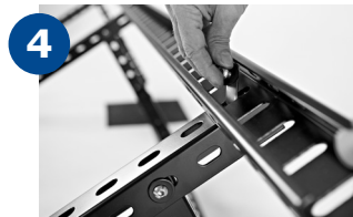
4 Panel-skinne lægges på knægte og drop-in bolte sættes løst i.
