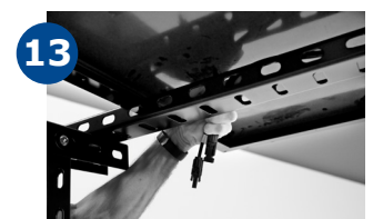
13 Ledninger fra solpanel lægges i panelskinne.
