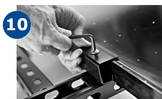
10 Solpaneler monteres med montagesæt ved start og slut.
