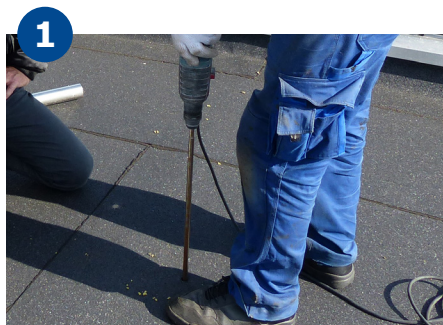
8 mm hul bores 80 mm ned i beton dæk.
