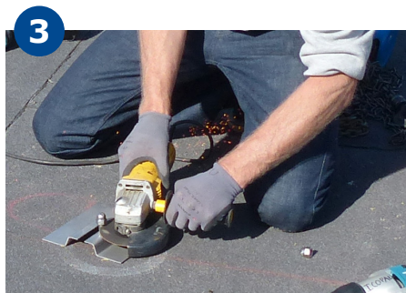
Gevindstangen afkortes efter skabelon.
