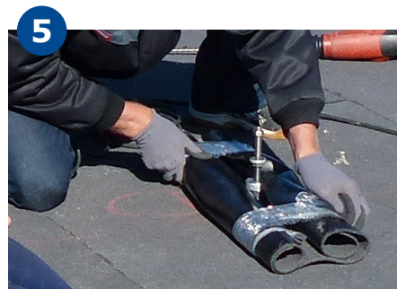
Universalfod spændes direkte ned på gevindstang, så der forbliver 100 % mekanisk forbindelse fra betonskrue, til konsolsystemet.
