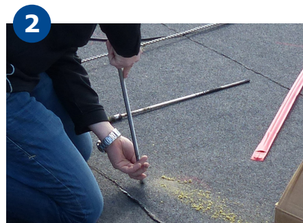
12 mm rustfri gevindstang med formonteret betonskrue, skrues helt ned i hullet.
